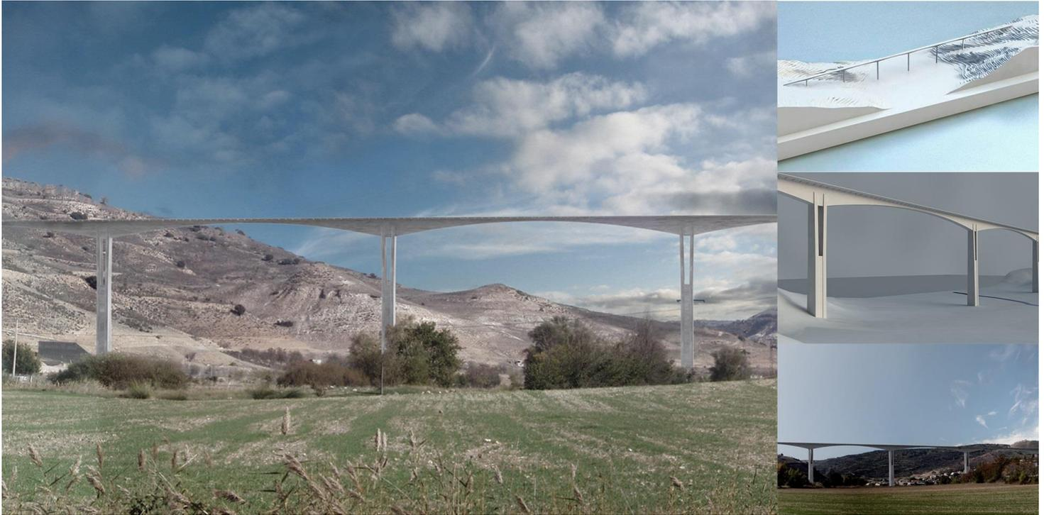
La estructura tiene 14 vanos con unas luces de  $40.0 + 3 \times 70.0 + 150.0 + 5 \times 250.0 + 150.0 + 2 \times 70.0 + 40.0$  metros, siendo la longitud total de 1980.0 m. El ancho del puente es de 24.00 metros, lo que permite albergar dos calzadas con dos carriles cada una.
